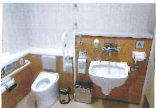
多目的トイレ
