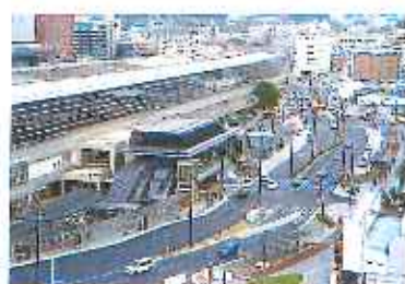
京都駅八条口整備後
